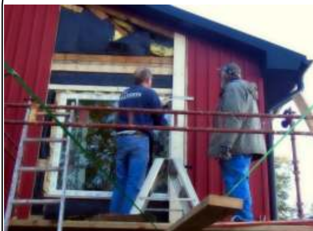
Lasse Johansson och Janne Carlsson byter fönster och panel.
