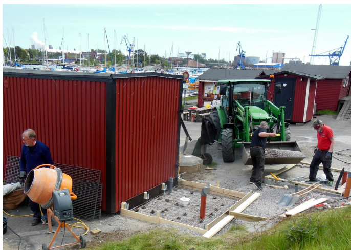
Janne Johansson, Kjell-Åke Johansson och "Janne" Carlsson lägger grund för utslagsvask och toalett.
