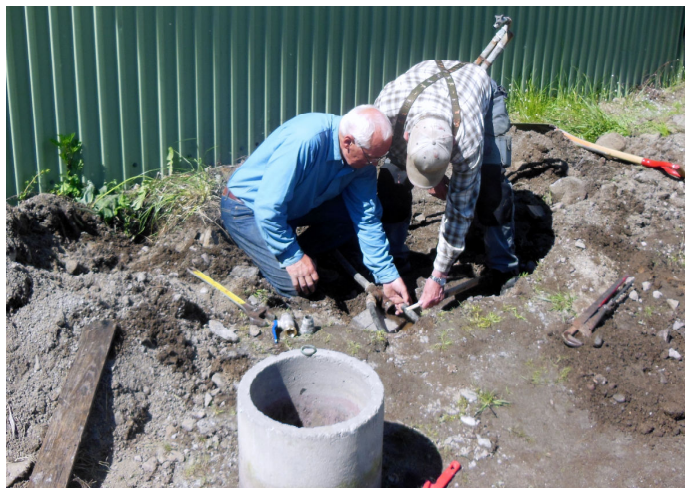
Leif Berg och Bernt Andersson förbereder byte av vattenledningar på hallområdet.
