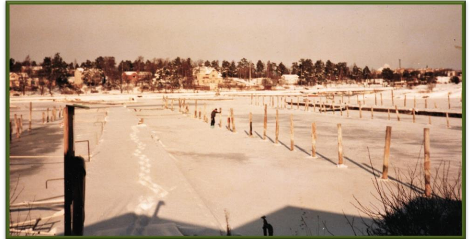
Lars-Olof Granqvist hackar is. Varje vinter var man tvungen att hacka runt stolparna så de inte skulle sjunka ner med isen. Det var ett hårt jobb.
