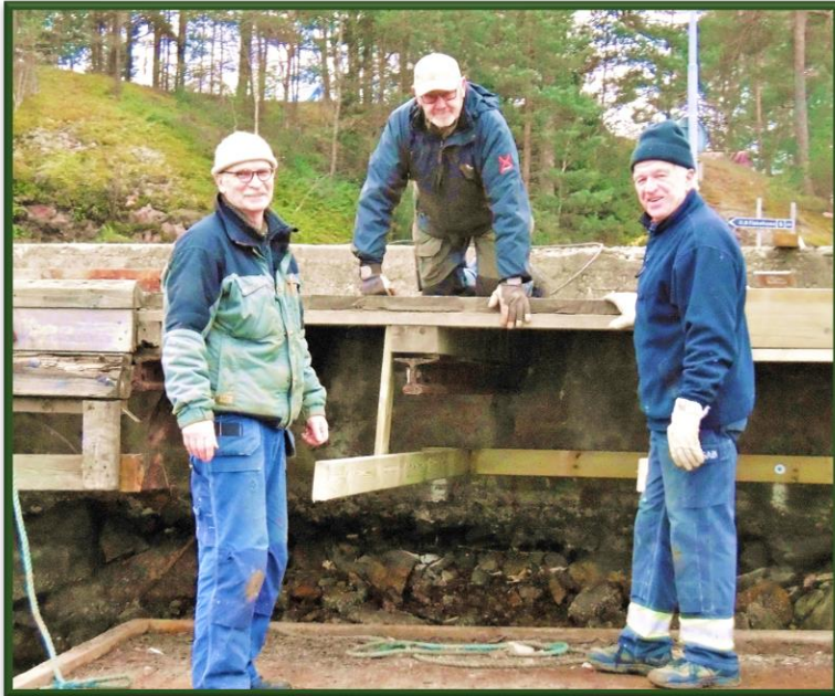
Även reparation av åretruntvatten till tvätten. Kurt-Lennart Karlsson, Bernt Andersson och Krister Karlsson
