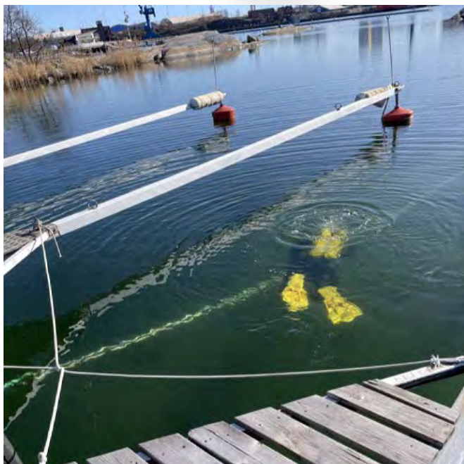
Inhyrd dykare kontrollerar kättingar och P-ringar
